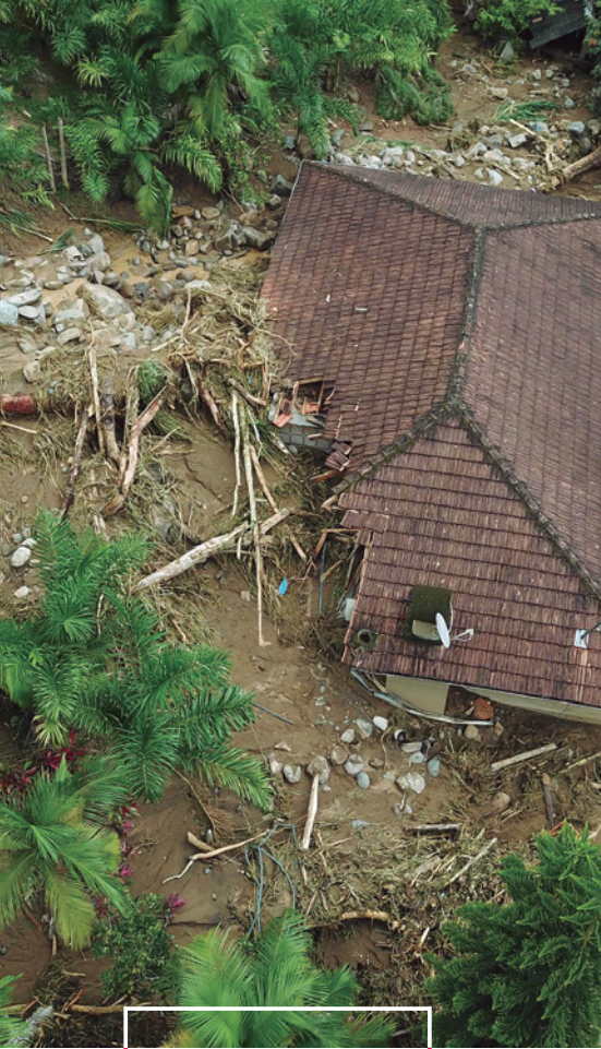
Deslizamento de terra em Rodeio (SC) em janeiro de 2023
