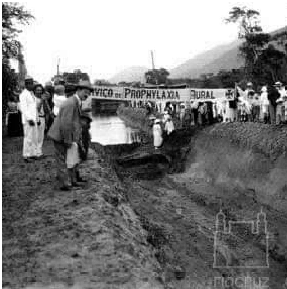
Inauguração do trecho aberto do Rio Sarapuí entre Mesquita e Engenheiro Neiva em Mesquita
